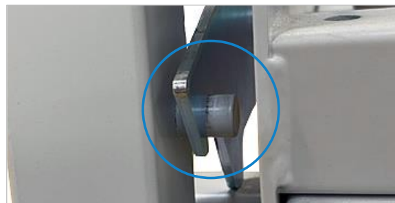
Figure 10: le cadre pivotant est enclenché verticalement
