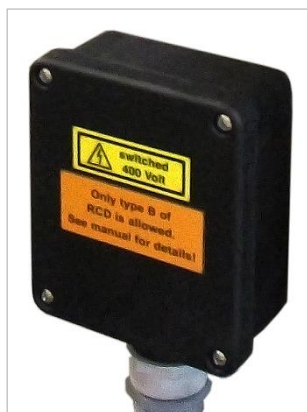
Figure 9 : boîte à bornes
