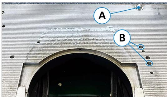
Figure 21 : boulons d'arrêt et trous d'arrêt
