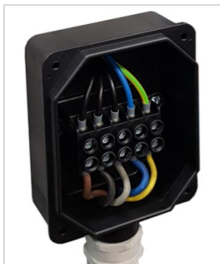
Figuur 9: Klemmenkast
