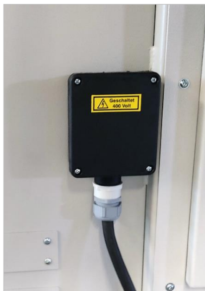
Figure 16 : boîte à bornes
