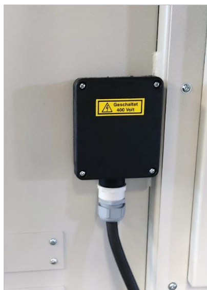
Figuur 16: Elektrische klemmenkast
