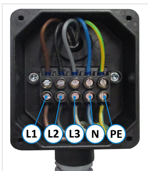
Abbildung 14: Anschlussbelegung
