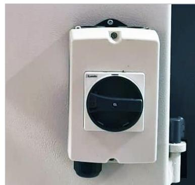
Abbildung 7: Hauptschaltergehäuse
