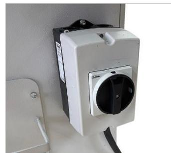
Abbildung 10: Hauptschaltergehäuse
