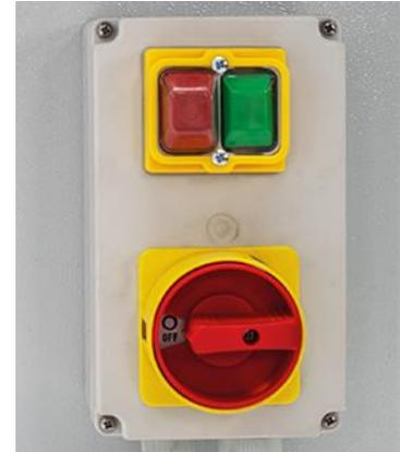
Abbildung 6: Hauptschaltergehäuse
